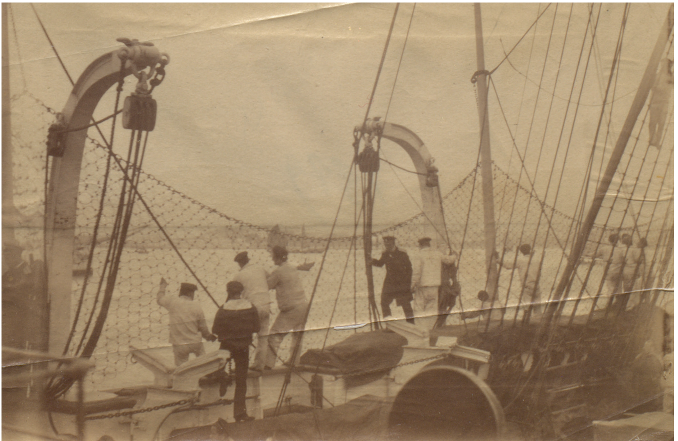
[В. И. Пароменский]. Учебная постановка противоминного сетевого заграждения командой корвета «Витязь». Дальний Восток. [1888]. Фотоотпечаток. 17 × 12. РГАВМФ. Ф. 17. Оп. 1. Д. 269. Л. 157. © ФКУ «Российский государственный архив Военно-Морского Флота»
