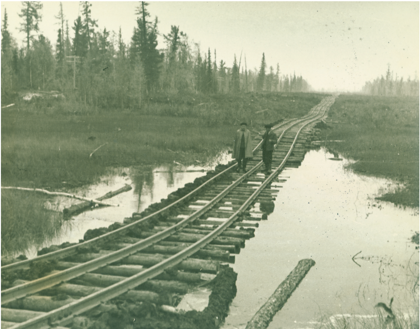
Неизвестный автор. Временная укладка пути через болото на км 1319. Из альбома фотографий «Железнодорожная линия Чум — Салехард — Игарка. Фотоальбом. Книга 2». 1949–1951. Фотоотпечаток. 23 × 28,5 (изображение); 37 × 44 (лист). ФГБУК ЦМЖТ России. КП 7364. Ф. 94. © Федеральное государственное бюджетное учреждение культуры «Центральный музей железнодорожного транспорта Российской Федерации»
